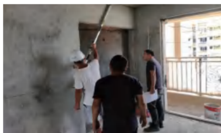
云东海项目33座塔楼装修分项实测实量
