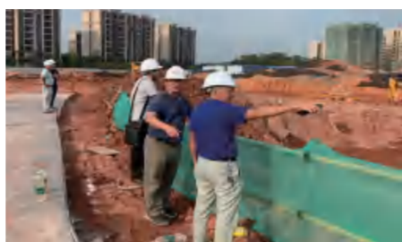
佛山云东海项目22座、23座基础验槽
