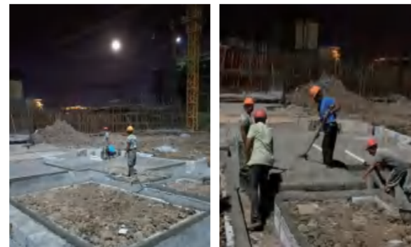
下图为建筑事业部金港汽车公园项目部利用晚间加班浇筑地下室垫层。
