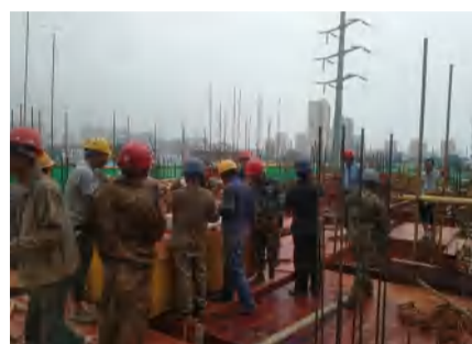
中泰大公馆木工班组加班加点
