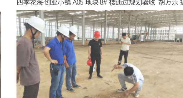
红安县泛家居产业园项目1#综合楼27#宿舍楼及5#厂房回填土压实度检测 魏小洁 摄
