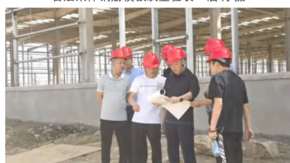
武穴市住建局领导在武穴天地项目督察售楼部首层架体钢筋模板质量验收 唐利 摄
