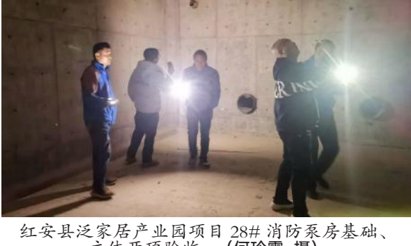
红安县迎家居产业园项目28#消防泵房基础、主体两项验收。(何玲霞 摄)
