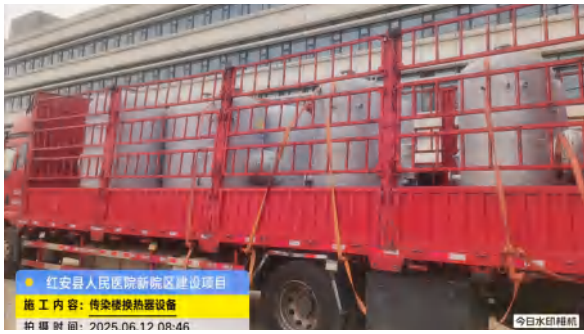
6月12日，红安县人民医院一期太阳能设备换热器到场安装（蔡泓明 摄）
