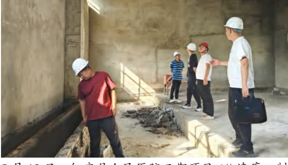
5月12日，红安县人民医院二期项目4#连廊、制氧结构验收（宋健 摄）
