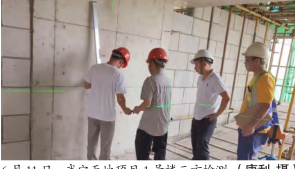
6月11日，武穴天地项目1号楼三方检测（唐利 摄）
